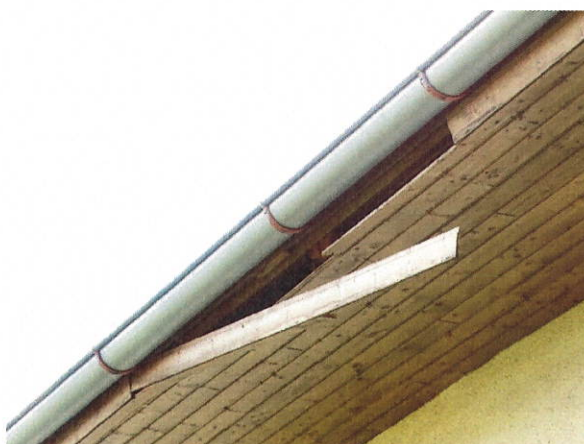
č. 27 Detaily poškození podbití, pavilon A, severní fasáda
