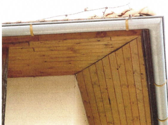
č. 23 – 26 Detaily dřevěného podbití přesahů střech, pavilony A a B
