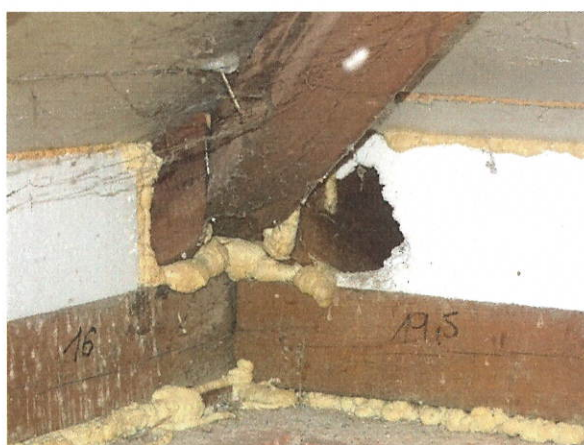
č. 36 – 38 Podstřeší pavilonu A, pobytové stopy kuny skalní na podlaze půdy a ve vrstvě tepelné izolace
