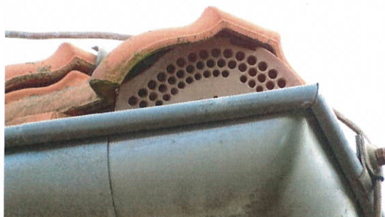
č. 17 – 20 Detaily zakončení hřebenů střech na pavilonech A a B
