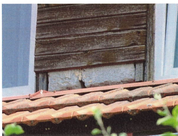
č. 49 Detail poškození obkladů vikýřových vestaveb, pavilon B, západní fasáda
