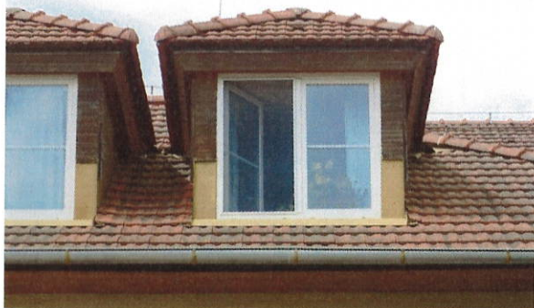
č. 16 Detail střešní krytiny a vikýřových oken půdních vestaveb
