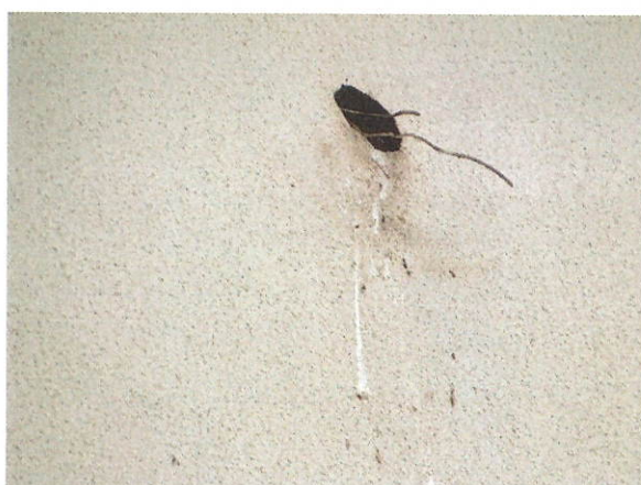
č. 44 – 48 Detaily poškození KZS, pavilon B, severní a západní fasáda
