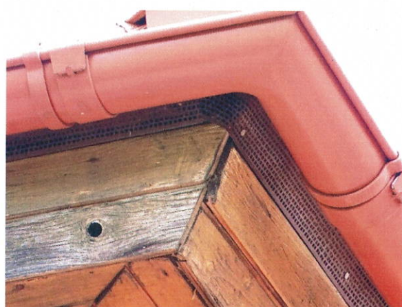
č. 21 – 22 Detaily perforovaných lišt pod stříškami vestaveb vikýřových oken, pavilon A
