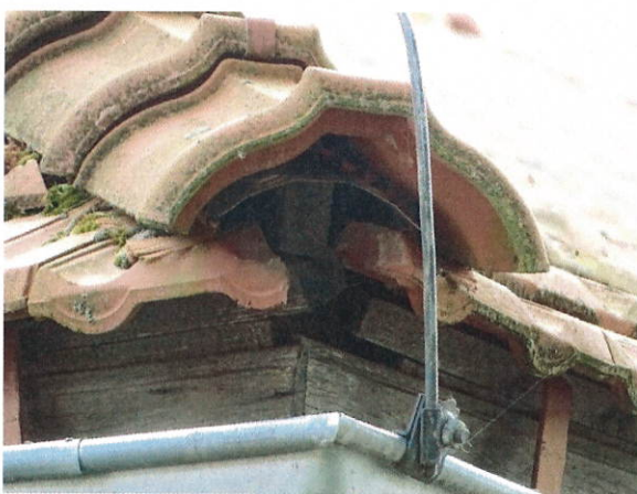
č. 17 – 20 Detaily zakončení hřebenů střech na pavilonech A a B
