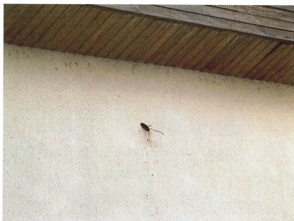
č. 44 – 48 Detaily poškození KZS, pavilon B, severní a západní fasáda
